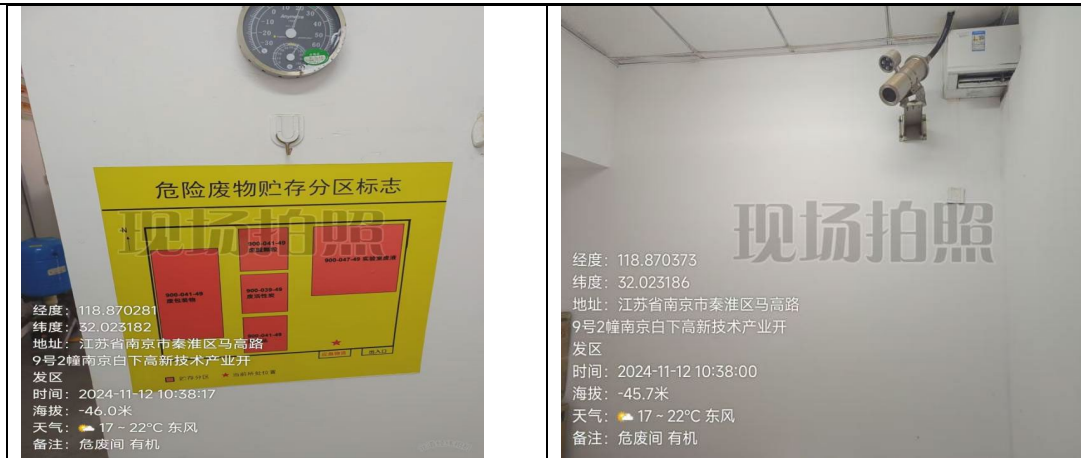
图 2-9 现有危废暂存间建设情况
